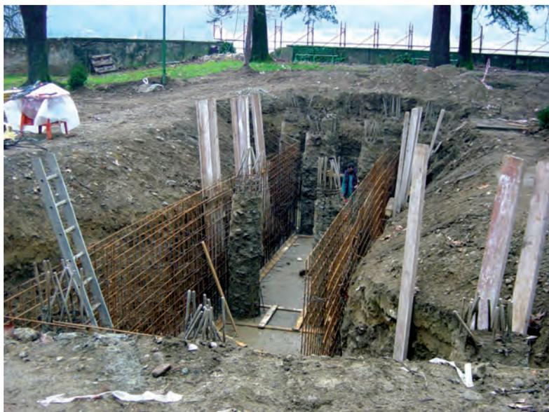
Fig. 9 - Realizzazione dello scatolare di cemento armato in corrispondenza del giardino del Cassero.
