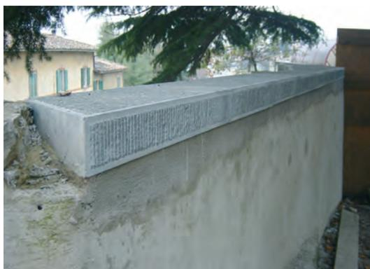
Fig. 12 - Lastre in arenaria a coronamento delle mura sui giardini.
