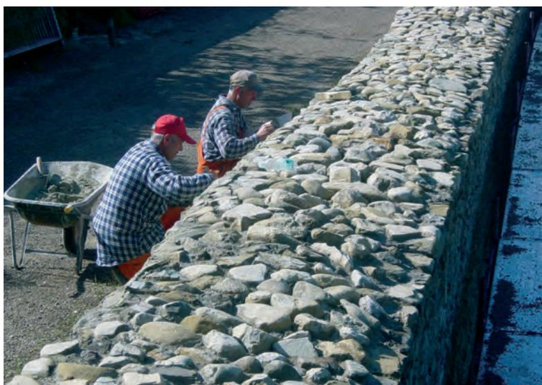
Fig. 8 - Bauletto con malta a base di calce realizzato sulla sommità delle mura.
