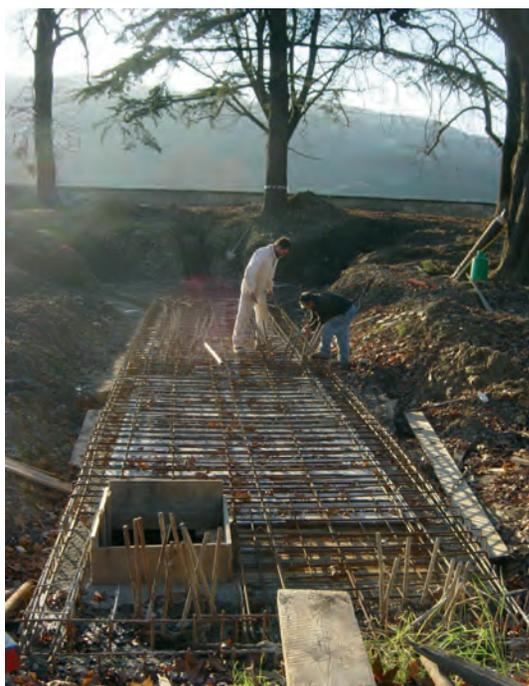
Fig. 11 - Una delle fasi finali della realizzazione dello scatolare.
