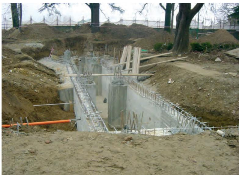
Fig. 10 - Una delle fasi finali della realizzazione dello scatolare.
